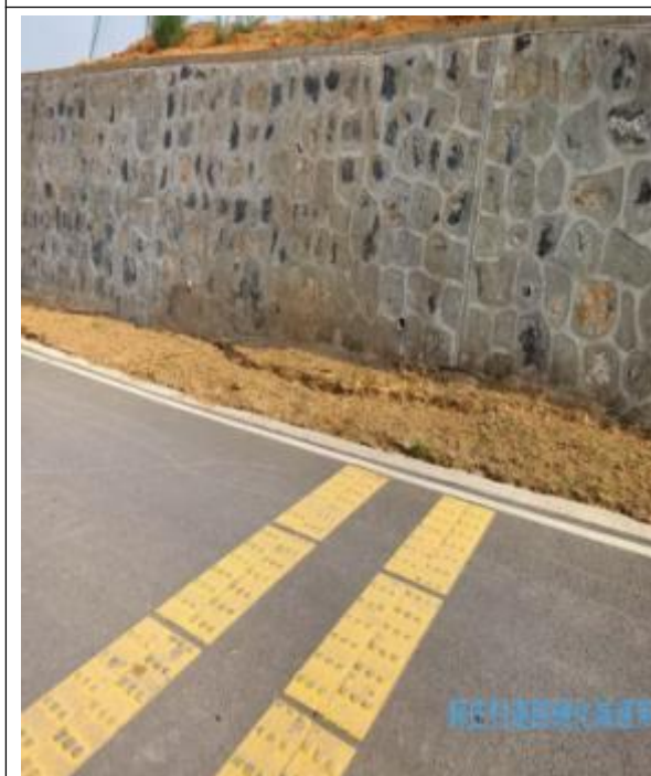
图 1-7 郭庄村道路硬化工程 减速带
