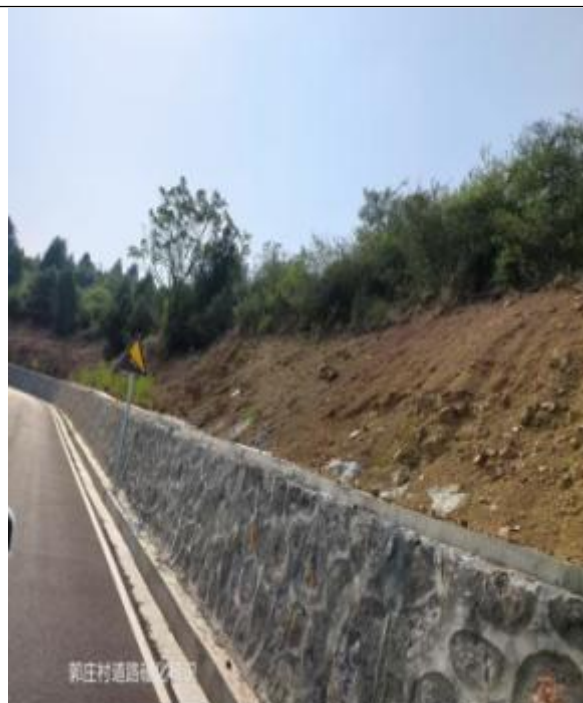
图 1-8 郭庄村道路硬化工程 安全防护
