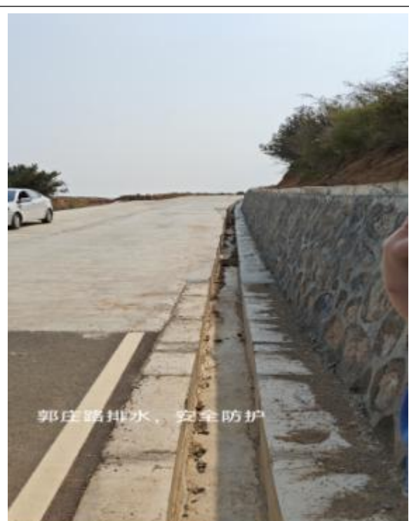
图 1-6 郭庄村道路硬化项目 排水沟
