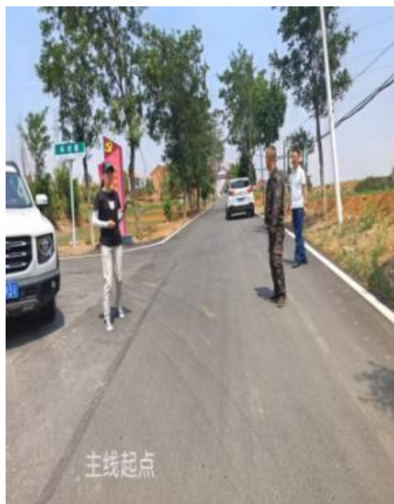
图 1-2 大阳-庙南沟项目 主线起点
