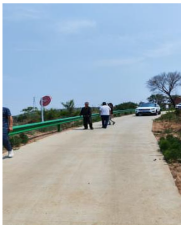
图 1-3 大阳-庙南沟项目 路面
