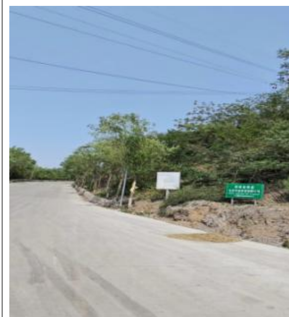
图 1-15 阳济线-岭后项目 路面
