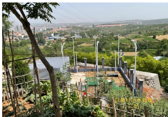
白桑村污水处理厂站
